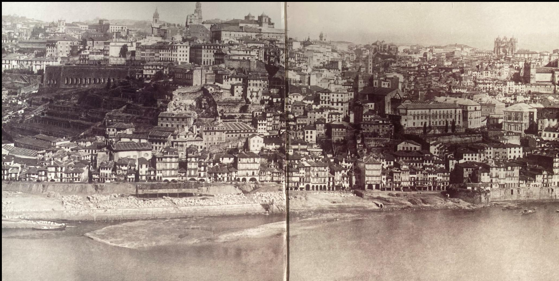
Início da construção da Alfândega. Excerto do Panorama em cinco partes – Foto Alvão (Casa Fritz_c.1860)
