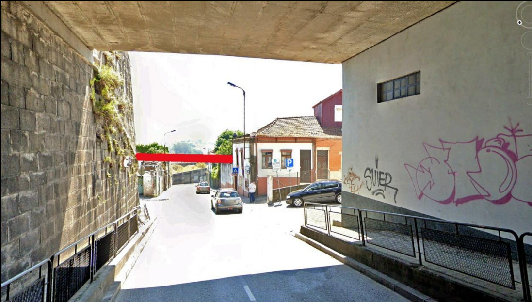
Interrupção na Rua do Pinheiro de Campanhã
