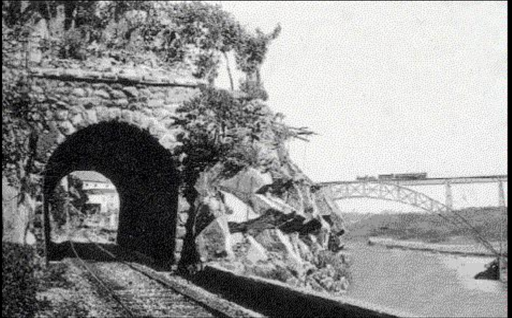
Túneis na encosta das Fontainhas
