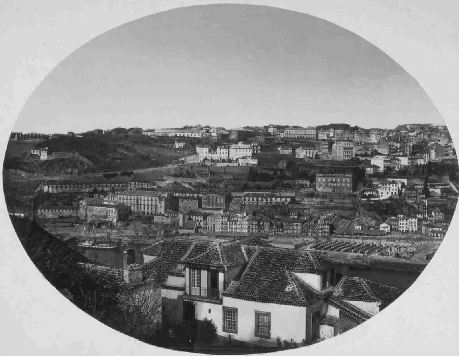
Início da construção da Alfândega (c.1860)
